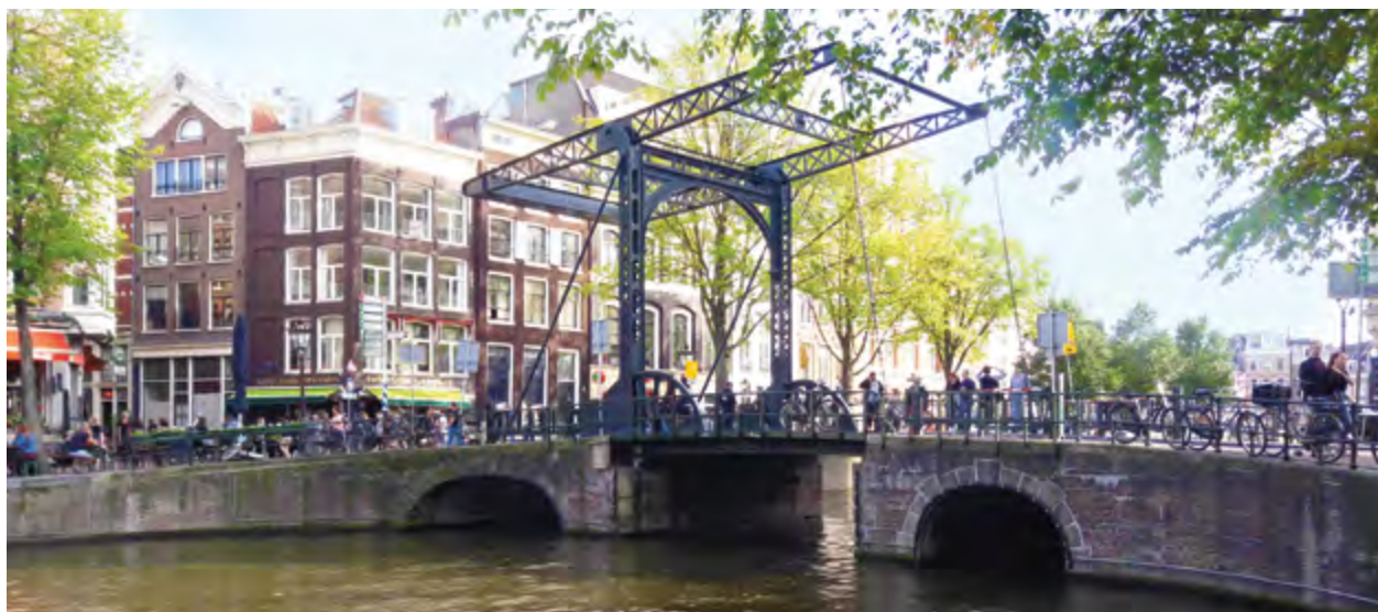
Aluminiumbrüg über den Kloveniersburgwal (Fotos: Marion Hanke)
